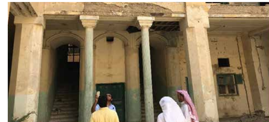
صورة 46 منظر لشرفتين تطلن على البهو الداخلي للمدخل الرئيس للقصر الملكي بالمعابدة وتظهر أعمدة حديثة بنيت لدعم الأييام beams الخشبية التي بدأت في التآكل (تصوير الباحثين بتاريخ 1439 /5/29هـ)
