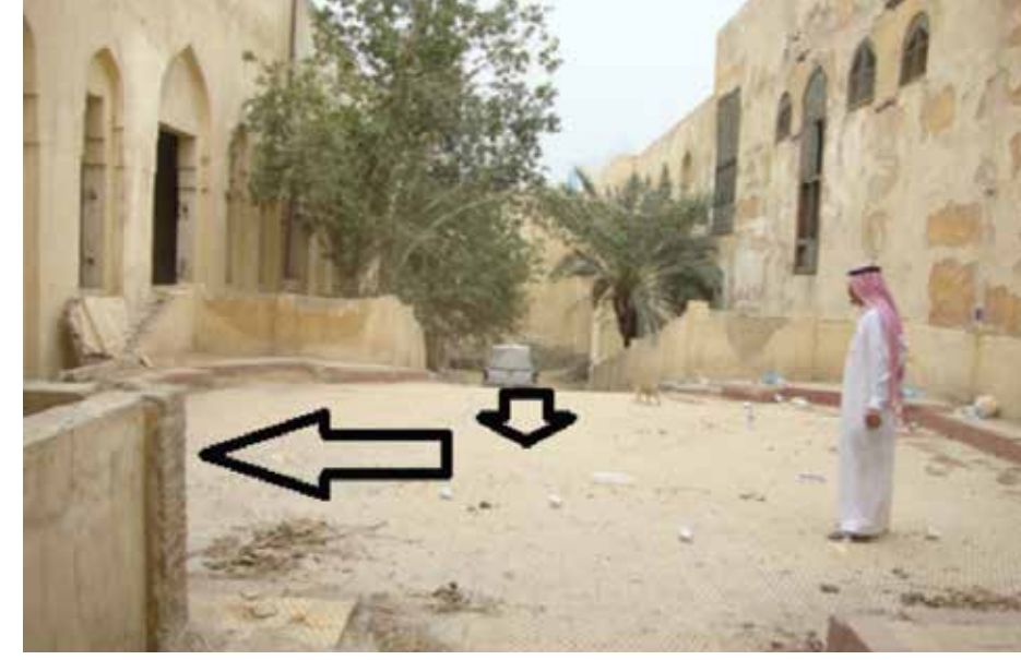
صورة 38 صورة طريق (Ramp) يصد به إلى الدور الأول للمسرح والقاعة الكبرى من القصر الرئيس عند مدخله من جهة الشرقية المصدر: دار الرياض DAR AL RIYAD للهندسة والمعمار (1439/5/29م)
